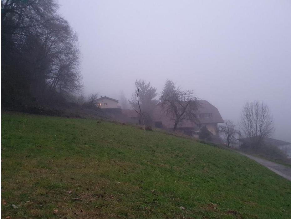
Abbildung 3: Transit- und Ablagerungsgebiet potentieller Hangmuren auf der Parzelle Nr. 1554. Im rechten Bildrand ist der Kutscherweg zu sehen (Foto U. Vetsch).
